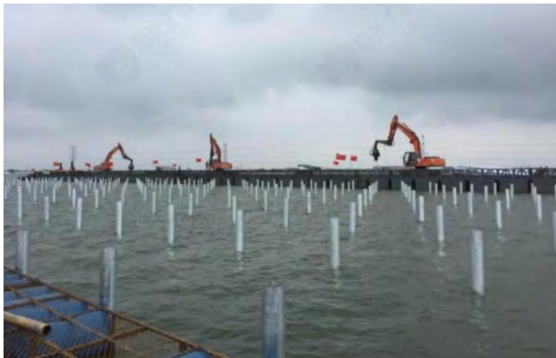
图 3.3-5 集装箱浮箱施工作业现场作业示意图
