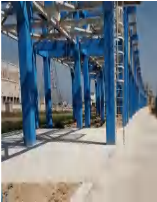
公共管廊的水泥混凝土路面及植被修复
